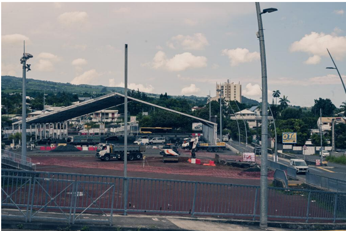
Les travaux se poursuivent au niveau de la place SIDR 400 en ce lundi 30 mars 2026.
