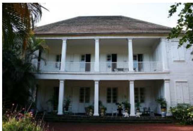
Figure 69 : Photo de la Maison Bel-Air
