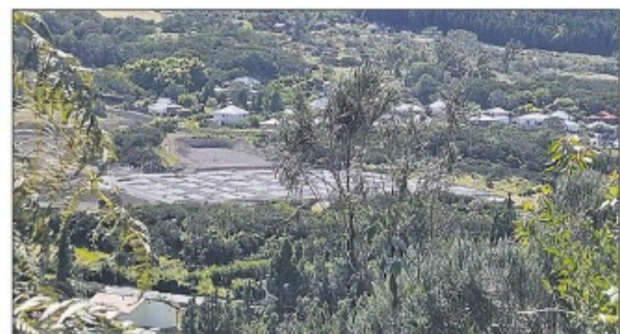
Photo au même endroit, après la construction du parking. (Photo DR)
