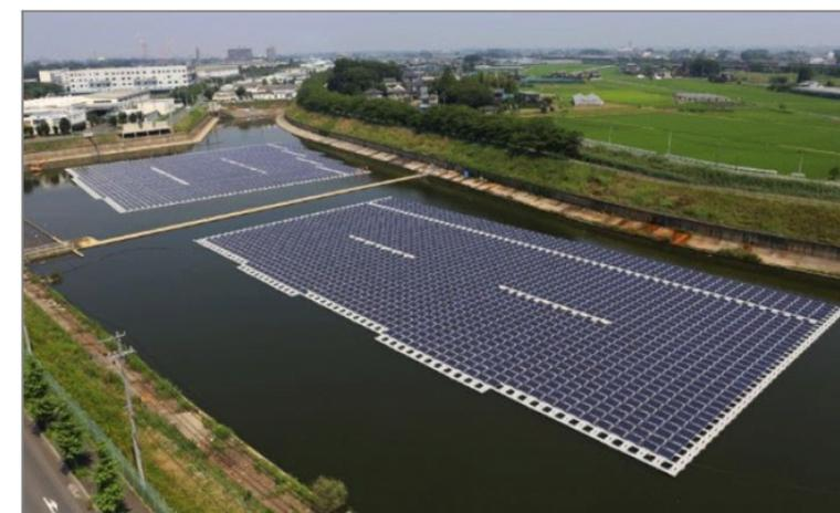
Figure 2 - Centrale photovoltaïque flottante au Japon d'une puissance de 1.2 MWc
